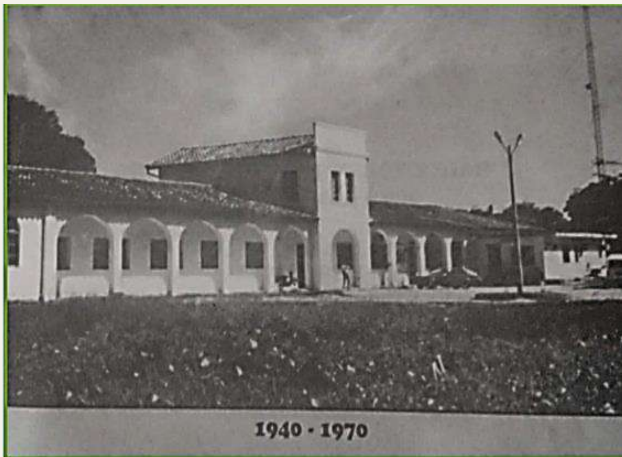
PRIMER EDIFICIO Facultad de Medicina Veterinaria (1940)
